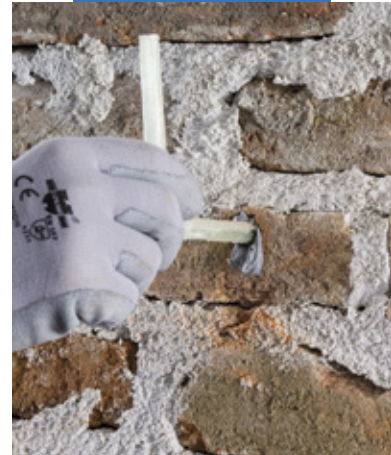
Inserting a MapeNet EM Connector
