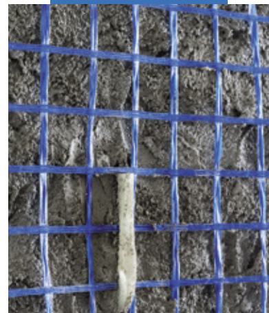
Mapenet EM placed in position
